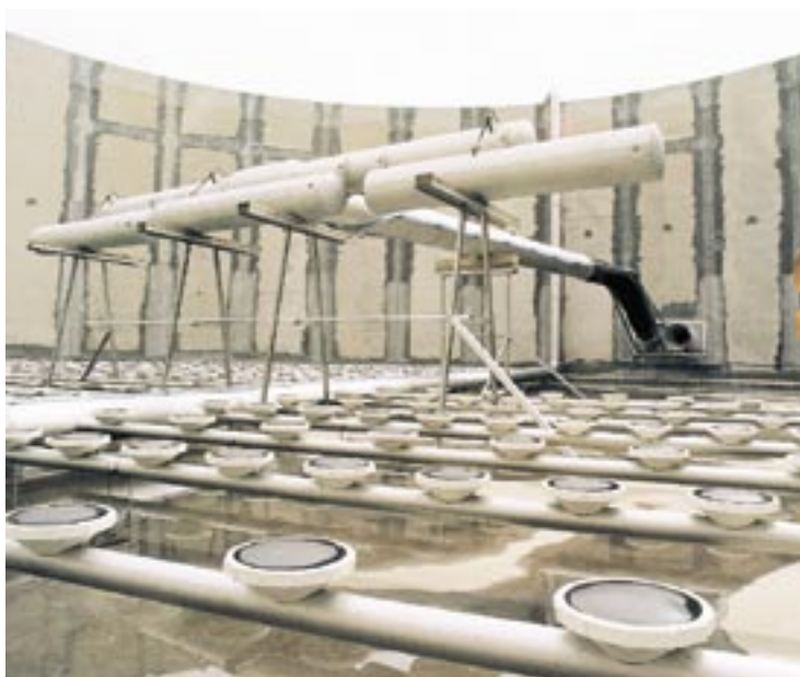
Läckeby Products dekanter auf der Kalmar ARA installiert.
