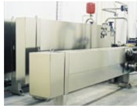
Läckeby Products Wärmetauscher Schlamm/Wasser und Wärmetauscheinheit "Schlamm/Schlamm" in Älmhult, Schweden.
