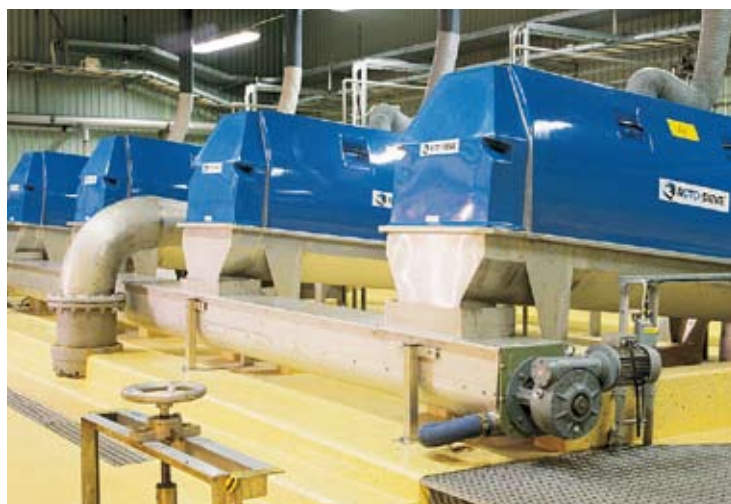
Installation av Roto-Sieve trumsilar modell 51 vid Kullaviks reningsverk i Kungsbacka.
